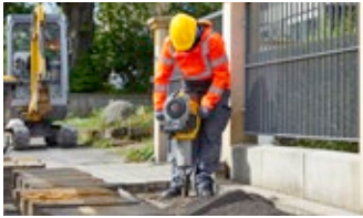
Tehnică de demolare
