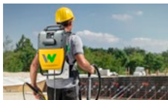
Technika na úpravu betonu
