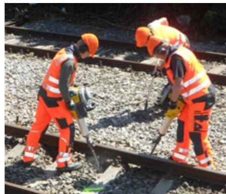
Bensinhammarna BH40 och BH55rw är särskilt optimerade för underhållsarbeten vid spårbyggen.
